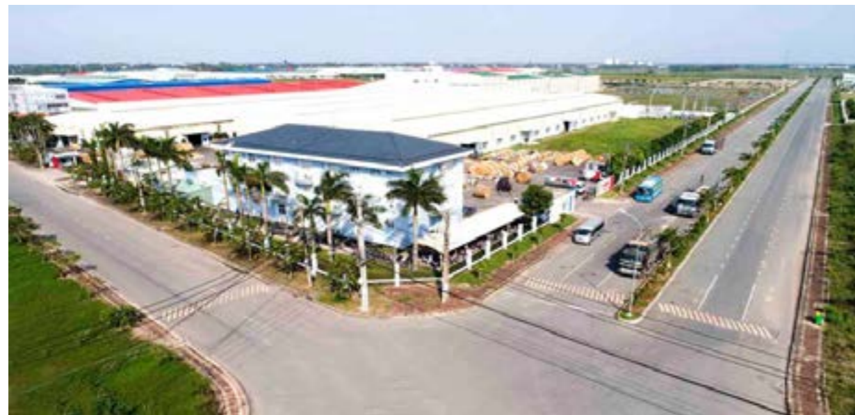
KCN Tân Phú Trung hoàn thiện hạ tầng
